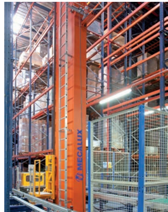
Almacén automático de doble profundidad (2).
